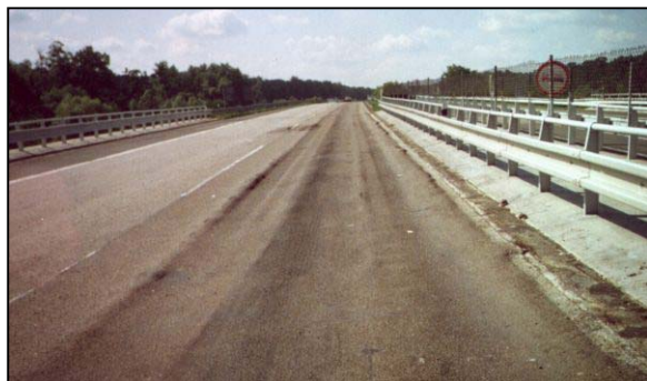
Obr. 1: Názorná ilustrace důsledků růstu zatížení vozidel
